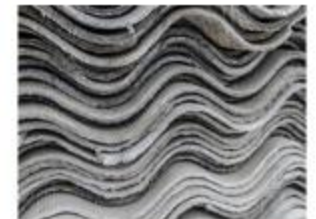
UPRAVLJANJE Z ODPADKI IN ODSTRANJEVANJE AZBESTA
