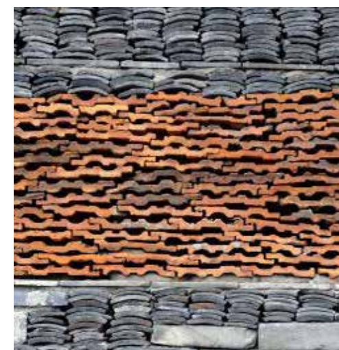
predelne stene (muzej in restavracija) ponovna uporaba: 60-80% tip uporabe: ponovna uporaba shranjen \text{CO}_2 : 29,1 \text{kg/m}^2
