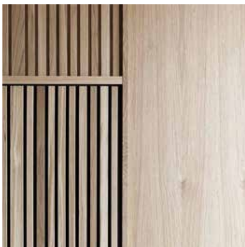
lesene obloge - akustika ponovna uporaba: 80-100% tip uporabe: večvrednostno recikliranje prihranek \text{CO}_2 : 4,5 \text{kg/m}^2
