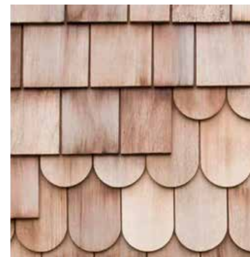
lesene obloge (predelne stene) ponovna uporaba: 100% tip uporabe: večvrednostno recikliranje prihranek \text{CO}_2 : 9,2 \text{kg/m}^2
