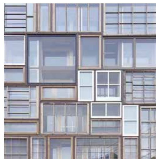
notranje steklo ponovna uporaba: 85% tip uporabe: ponovna uporaba shranjen \text{CO}_2 : 52,9 \text{kg/m}^2
